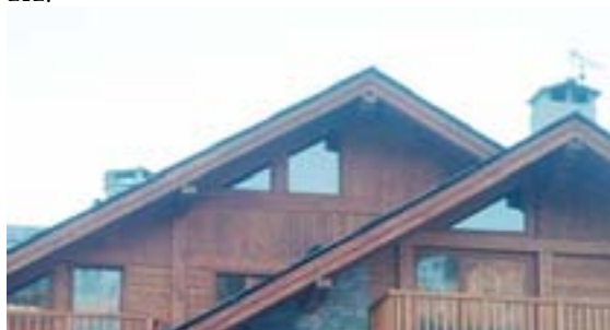
211. Aperture tradizionali a nastro poste sotto una falda del tetto
