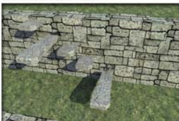
Tipologia di muro a secco con gradini aggettanti
