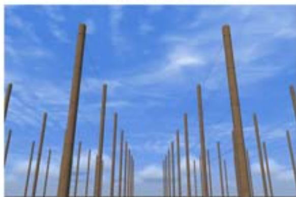
Vista frontale dei pali di testata
