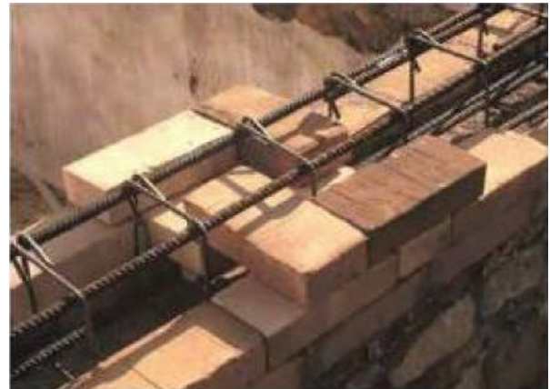
Esempio di cordolo in muratura armata
