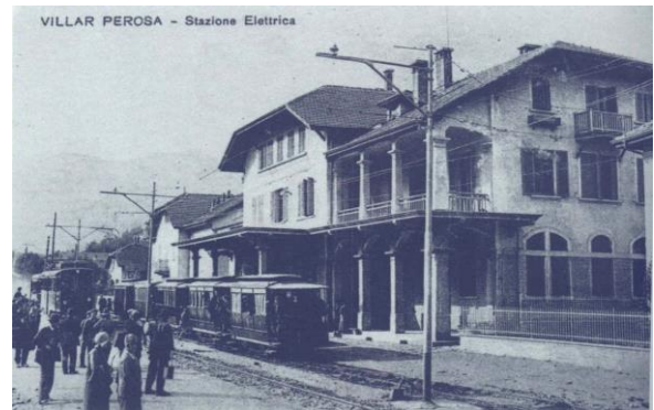
Villaggio "Edoardo Agnelli": stazione
