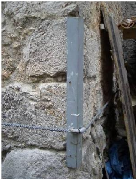
Esempi di cerchiatura esterna per tirantatura a cavo
