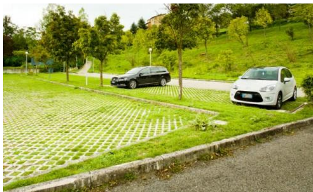
Esempio di parcheggio drenante
